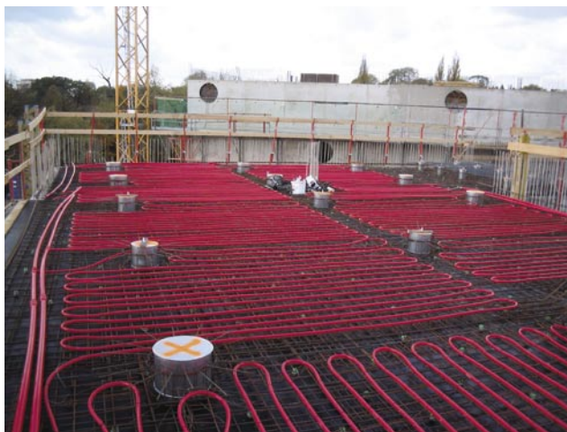
Stavba Knihovnicko-informačního centra v Hradci Králové
