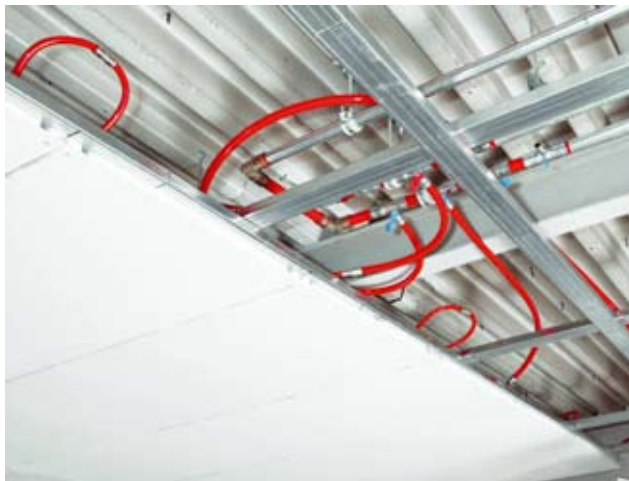
Stropné chladenie „suché“: prefabrikované sadrokartónové dosky
