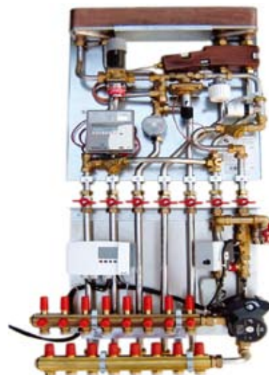
Príklad použitia ventilu AVTB vo výmenníkovej stanici určenej pre podlahové vykurovanie v závislosti od vonkajšej teploty (ekvitermická regulácia):
