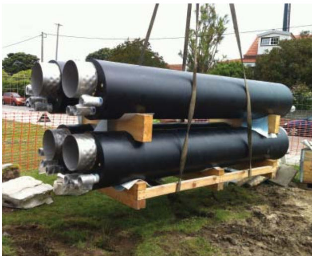
Obr. 5: Predizolované kanalizačné potrubie s integrovaným oceleovým výmenníkom tepla [3]
