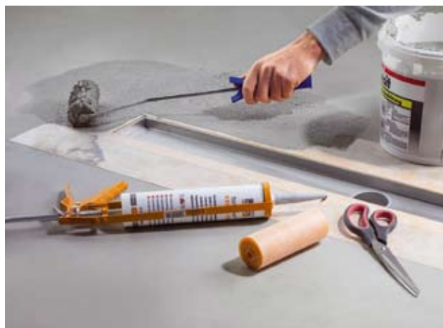
Priložená izolačná páska sa zapracuje do prvej vrstvy hydroizolácie. Potom nadväzuje obklad. (Foto: Viega)
