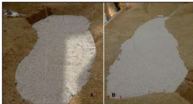
Obr. 5: A – Vrstva perlitu predstavujúceho vzdutie hladiny na hrádza o 5m. B – Perlit aplikovaný pre výške hladiny 10m.
