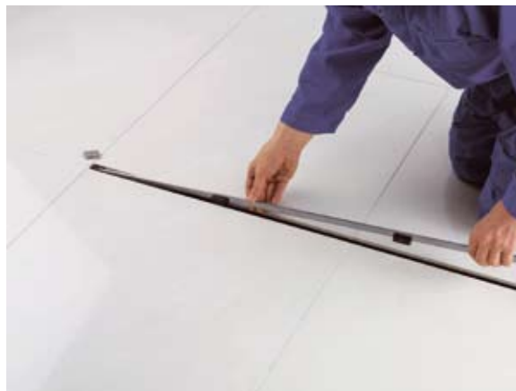
Montážny obr. 6: Nasadíte krycí rošt a pomocou nožičiek upravíte jeho výšku presne podľa výšky dlaždíc. (Foto: Viega)
