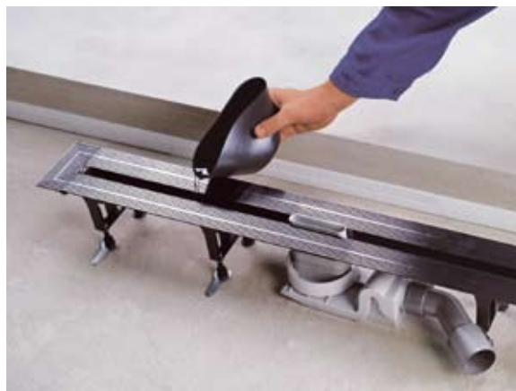
Montážny obr. 4: Skontrolujte tesnosť ukončovacích krytiiek. Za týmto účelom vsuňte do odtokového otvoru skúšobnú rúčku a žliabok naplňte vodou. (Foto: Viega)
