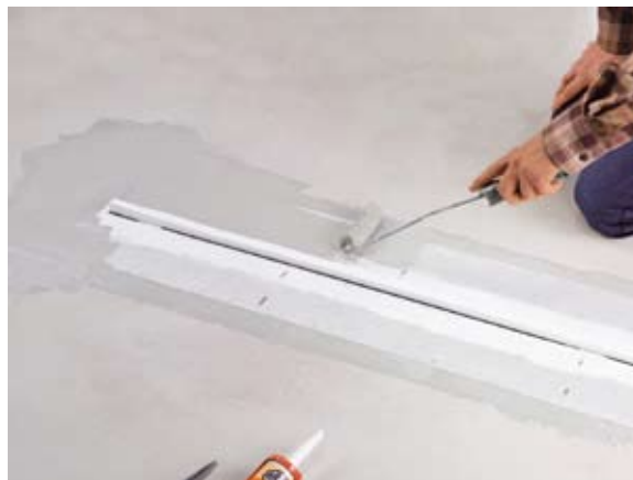
Montážny obr. 5: Po nalepení a zatmelení izolačnej pásky na prírbu žliabku potom naneste druhú vrstvu tekutej fólie. (Foto: Viega)
