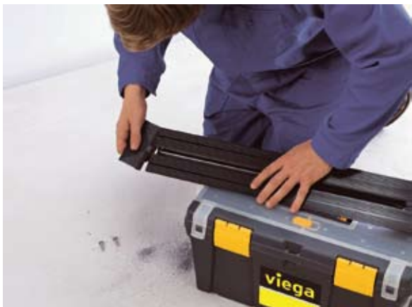
Montážny obr. 3: Na konce nasadíte ukončovacie krytky a priskrutkujete ich. (Foto: Viega)
