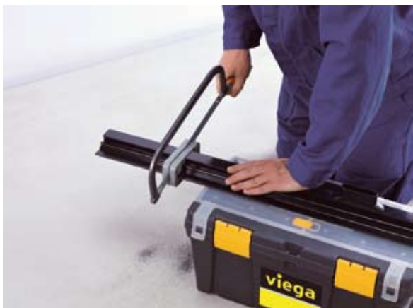
Montážny obr. 1: Základné teleso sprchového žliabku odrežete ručnou pílkou presne na vonkajší rozmer, ktorý potrebujete. (Foto: Viega)
