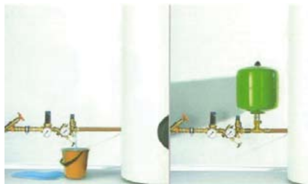
Obr. 3: Sústava s poistným ventilom bez expanznej nádoby a sústava s poistným ventilom s expanznou nádobou [10]
