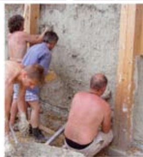
Obrázok 3: Postup kladenia jednotlivých vrstiev izolácie: slama – konopné panely – hlinená omiетка.
