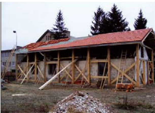
Obrázok 1: Pôvodná budova a výstavba samonosnej nadstavbovej drevenej konštrukcie a strechy
