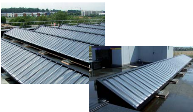
Obr. 4: Strešný typ vzduchového kolektora
