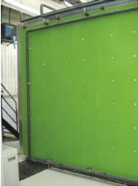
Obr. 3. Rozvody chladiacej vody
