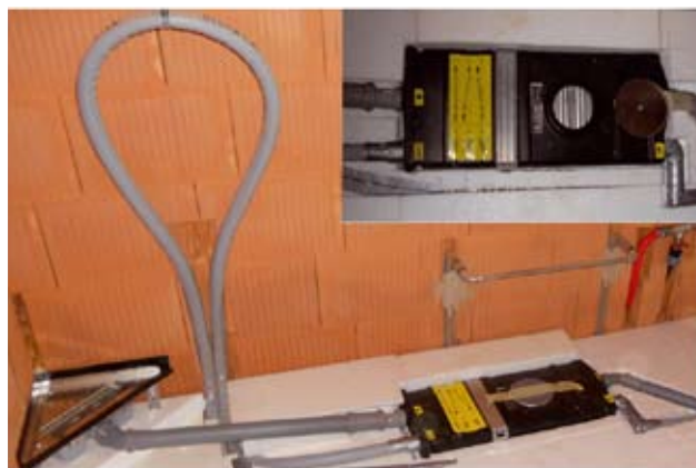
Obr.5: Inštalácia rekuperačného panela v sprchovom kúte rodinného domu [7]
