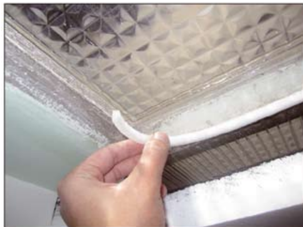
Obr. 3: Detail výdychu kolektora pri osadzovaní PUR tesnenia na plochu čela spodného kolektora
